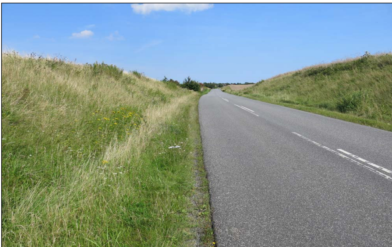
Fanefjordsgade med kalkoverdrev på vejskrænterne (Foto CH).
