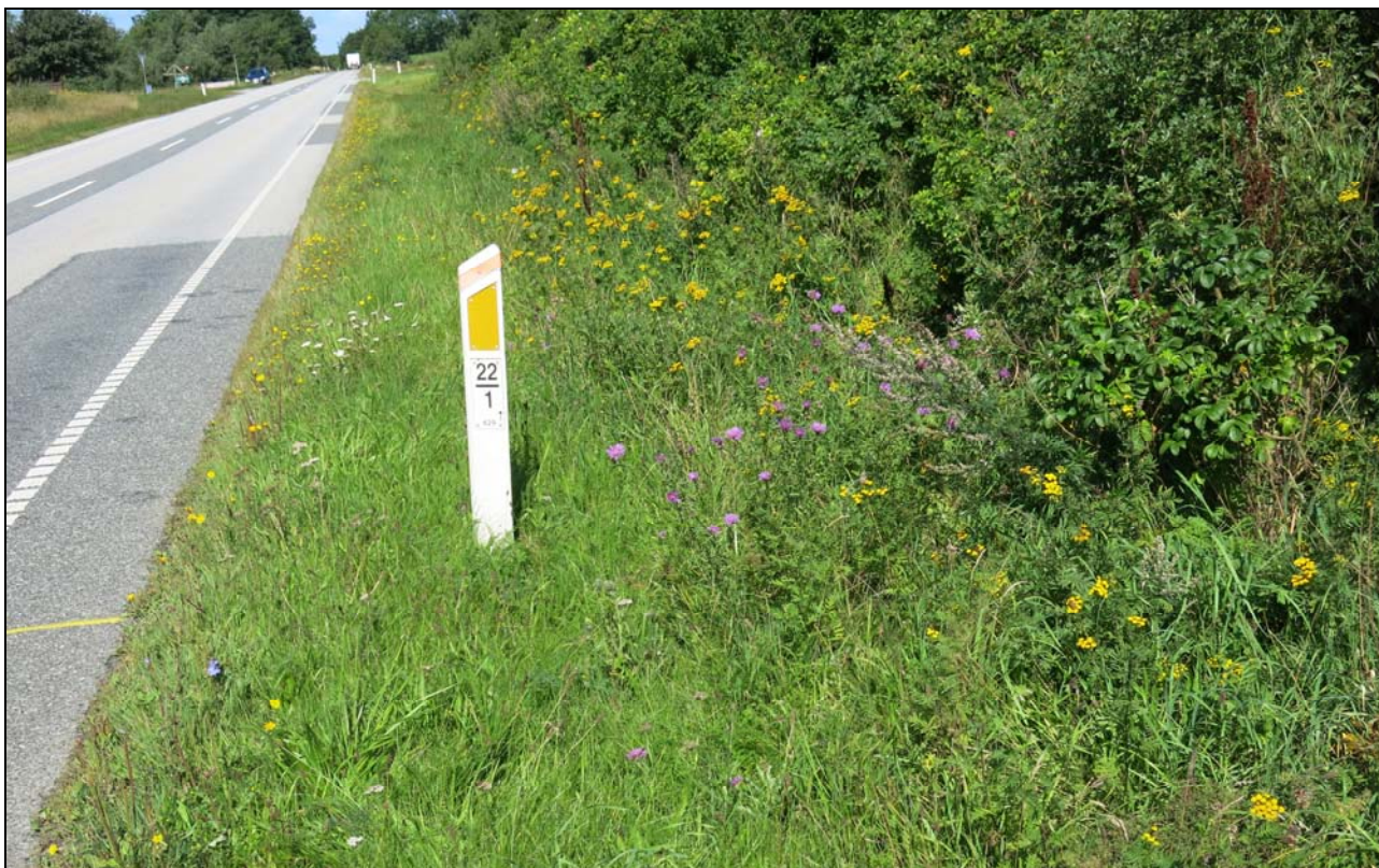
Grønsundvej på Bogø - en smal vejkant, der kunne udvides ved rydning på den tilgroede vejskrænt (Foto: BK).
